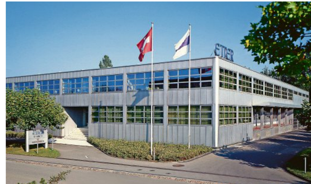
1980: Die drei Geschwister Josy, Hans und Paul erstellen einen modernen, grosszügigen Neubau an der Stadtgrenze von Zug.
